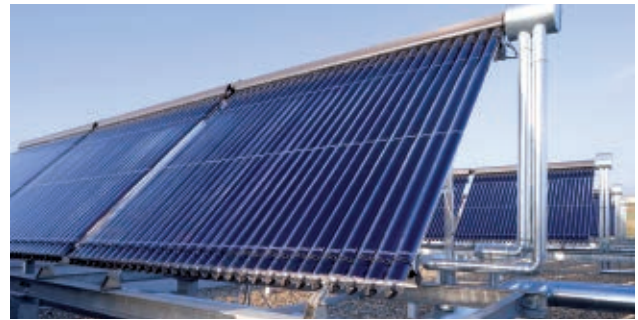
Abb. 45: Anlagenbeispiel – Vakuumröhrenkolloktor
