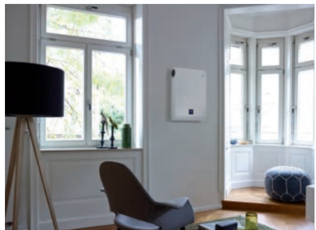
Abb. 82: Raumweises (dezentrales) Lüftungsgerät
