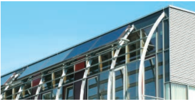
Abb. 44: Anlagenbeispiel – Flachkolloktor
