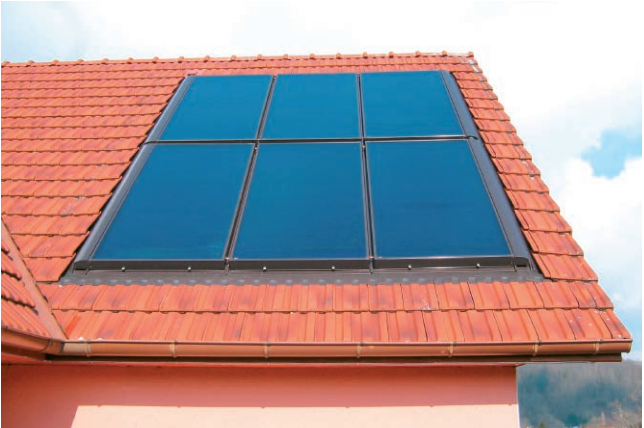
Abb. 49: Praxisbeispiel für die Anwendung von Solarthermie-Flachkollektoren
