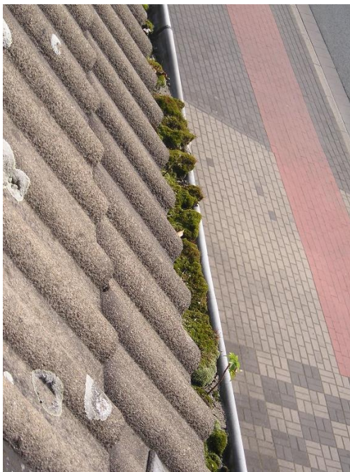
Foto: Regenrinnen, Einläufe Flachdach etc. - Quelle wird noch ergänzt
